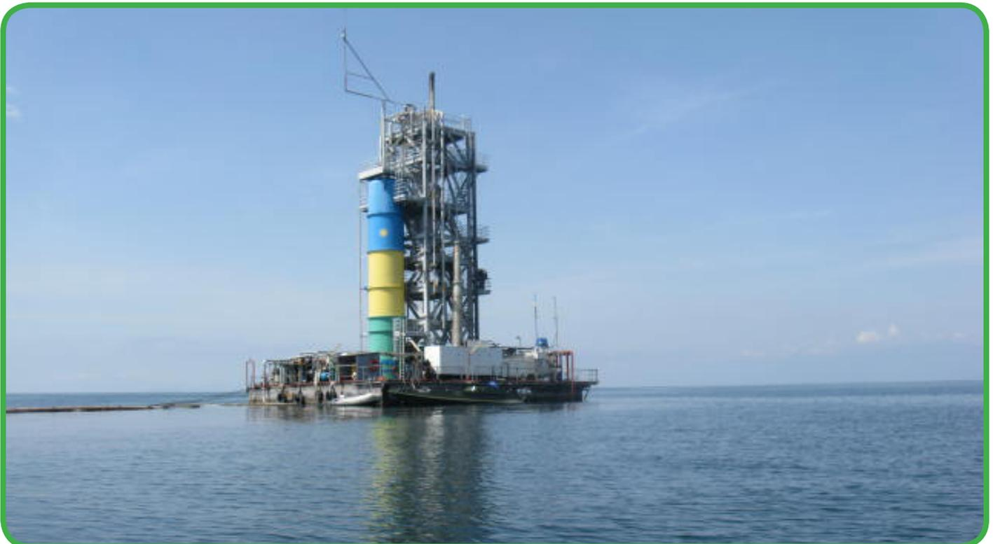
*Une installation flottante sur Lac Kivu pour pomper le gaz méthane. Photo par Faustin Gashakamba/ARCOS*
