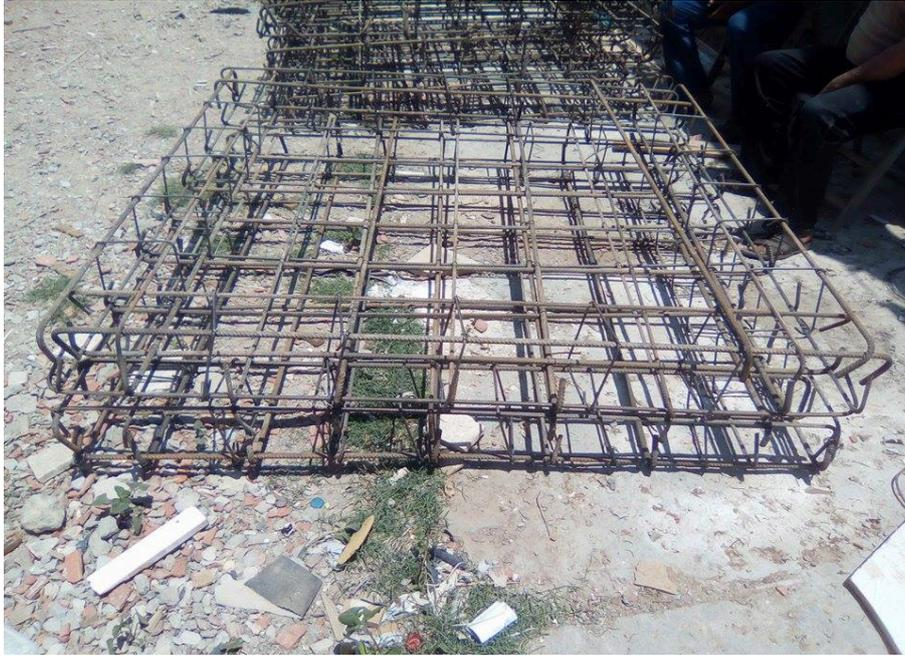
Figure 19 : le ferrailage du corps mort
