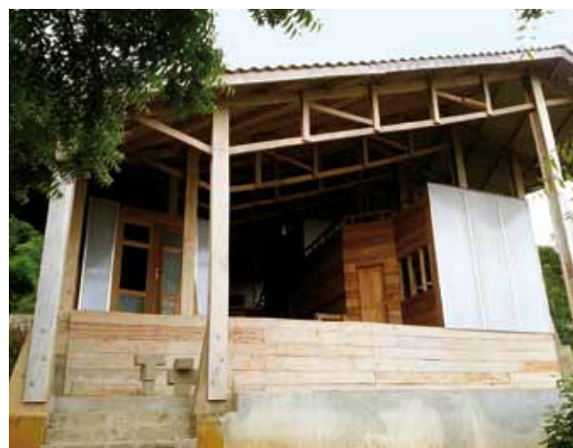
Photo 4. EFA Learning Center en construction près de Freetown, Sierra Leone (décembre 2013)
